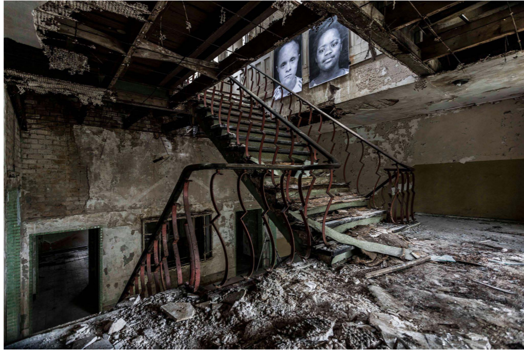
Afbeelding 5.4.48: Zichtbaar is het tussendeck van de trap in de galerij. De balustrades van het trappenhuis bestaan uit sierlijk decoratief smeedwerk. wat niet goed zichtbaar is maar hoogstwaarschijnlijk bestaat de trap uit ijzeren trappbomen die afgetimmerd zijn met nog onbekend materiaal..
