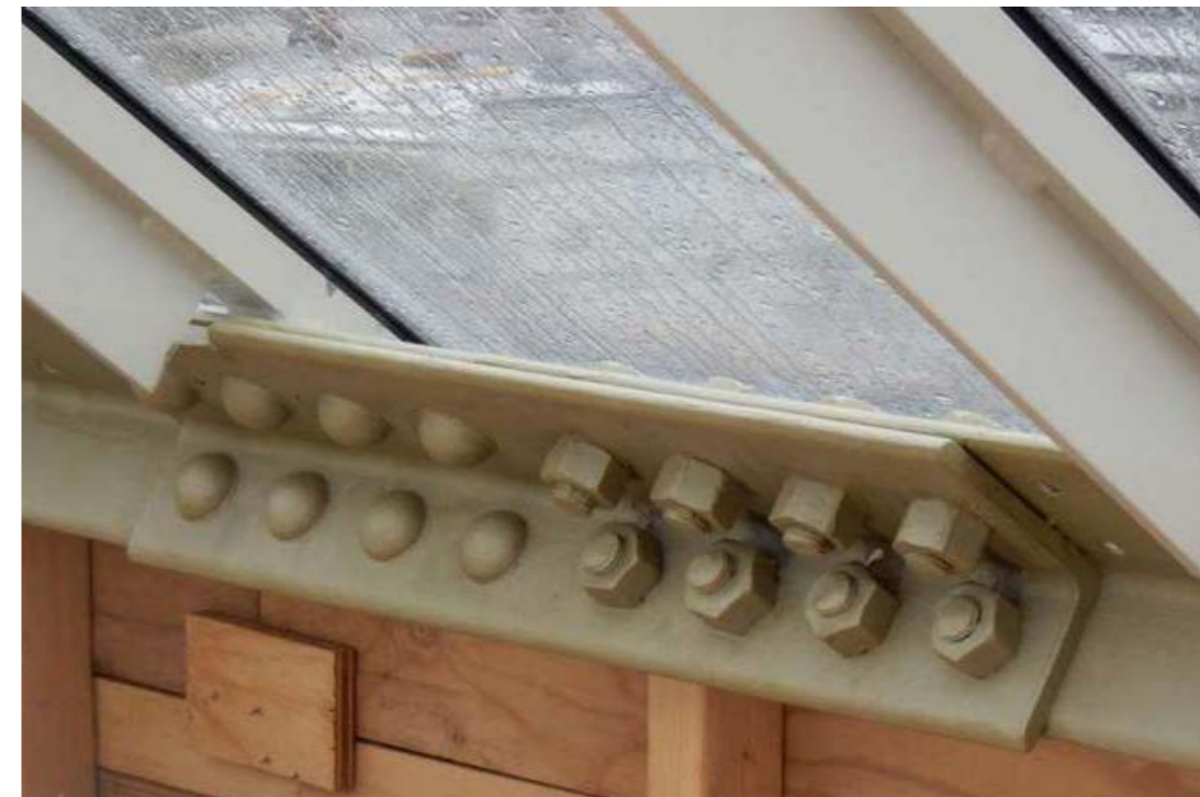
Afbeelding 5.4.63: Verbinding van de lichtstraat na de restauratie
