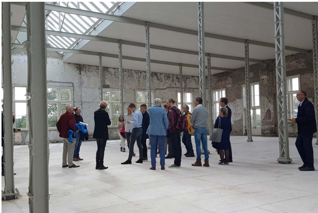
Afbeelding 5.4.57: De eerste verdieping na de restauratie
