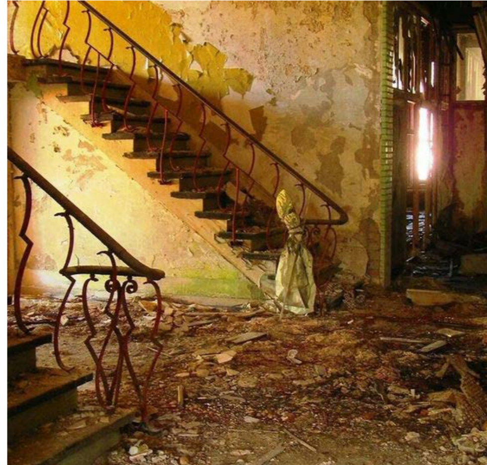
Afbeelding 5.4.50: De trap is voorzien van gebogen leuning ten opzichte van de eerste aanzet. Inde afbeelding is in de sparing in de muur tegels zichtbaar die accent gevel aan de openingen. Aan de hoekafsluiting aansluiten aan de sparing is te vernemen dat langs het middenblok in het gebouw de ruimtes rondom worden ontsloten.
