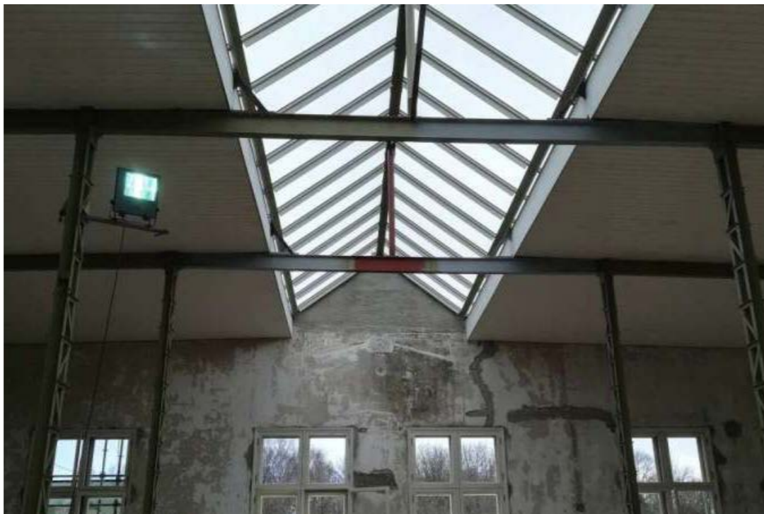
Afbeelding 5.4.62: De lichtstraat vanuit Gebouw 8 na de restauratie
