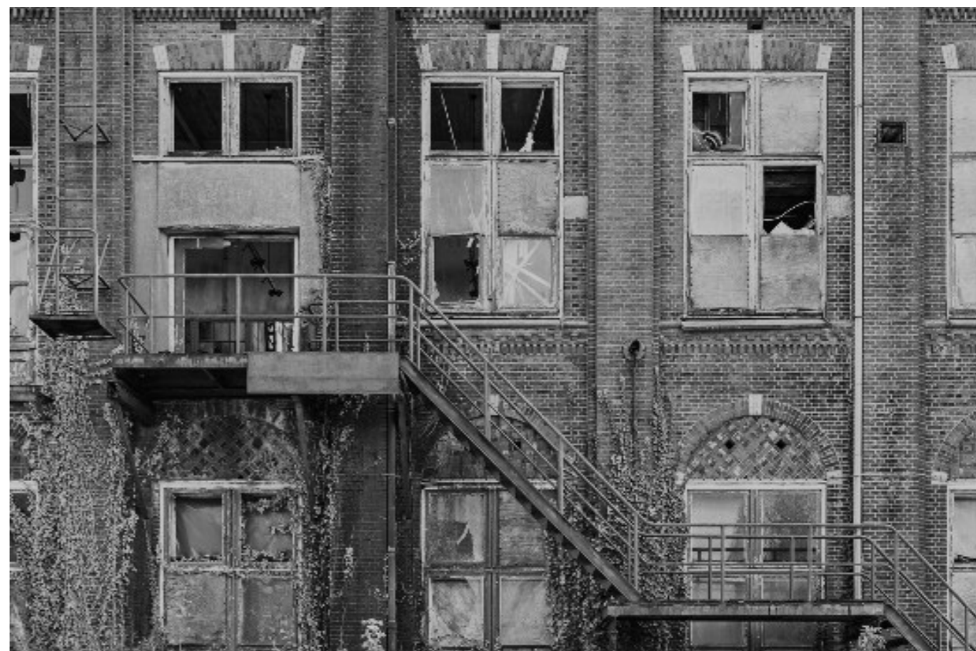
Afbeelding 5.4.28: Vluchtrappenhuis aan de westgevel
