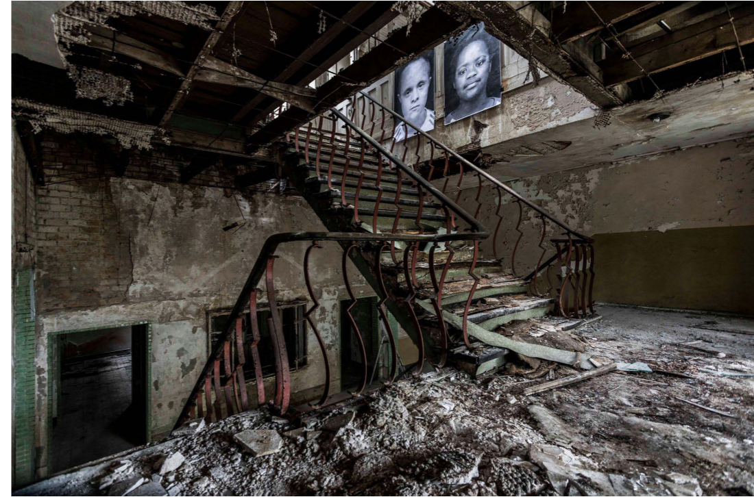
Afbeelding 5.4.58: Het trappenhuis voor de restauratie
