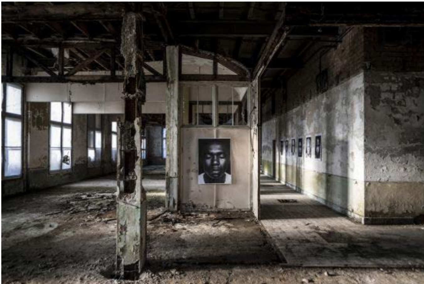
Afbeelding 5.4.46: (begane grond) In de afbeelding zijn nog restanten van het interieur zichtbaar vanuit de jaren 50. Zo zijn de kolommen bekleed en een overmaats houten venster aangrenzend aan het plafond zichtbaar. Naast de kolomconstructie is nog een overblijfsel aanwezig van een kozijnportaal waar hoogstwaarschijnlijk vroeger glaswerk in heeft gezeten. Hiermee werden de ruimtes van elkaar gescheiden.
