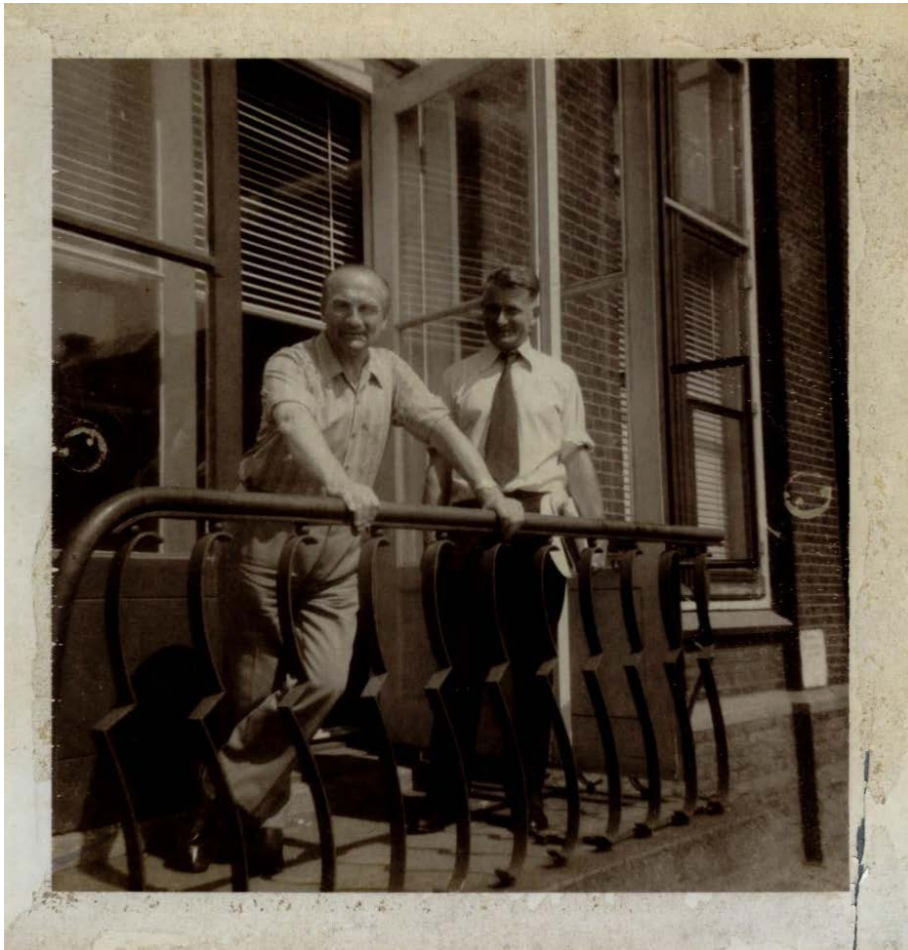
Afbeelding 5.4.35: De oude entree, aan de zuidgevel, werden getransformeerd naar balkons
