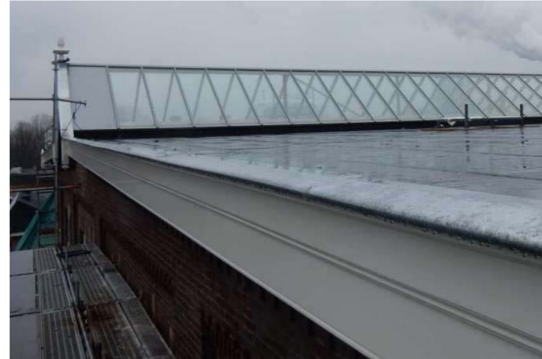
Afbeelding 5.4.61: Het dak en de lichtstraat na de restauratie
