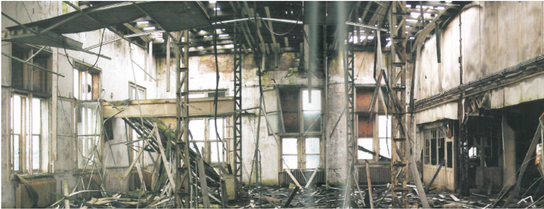
Afbeelding 5.4.31: Aanvankelijk zichtbaar aan het middelste kozijn gaat het om de ruimte die grenst aan de oostgevel en zal het bij de linkergevel om de noordgevel gaan. Rechts in de afbeelding is te zien dat er achter de betimmering een stalen vakwerk ligger zich bevindt
