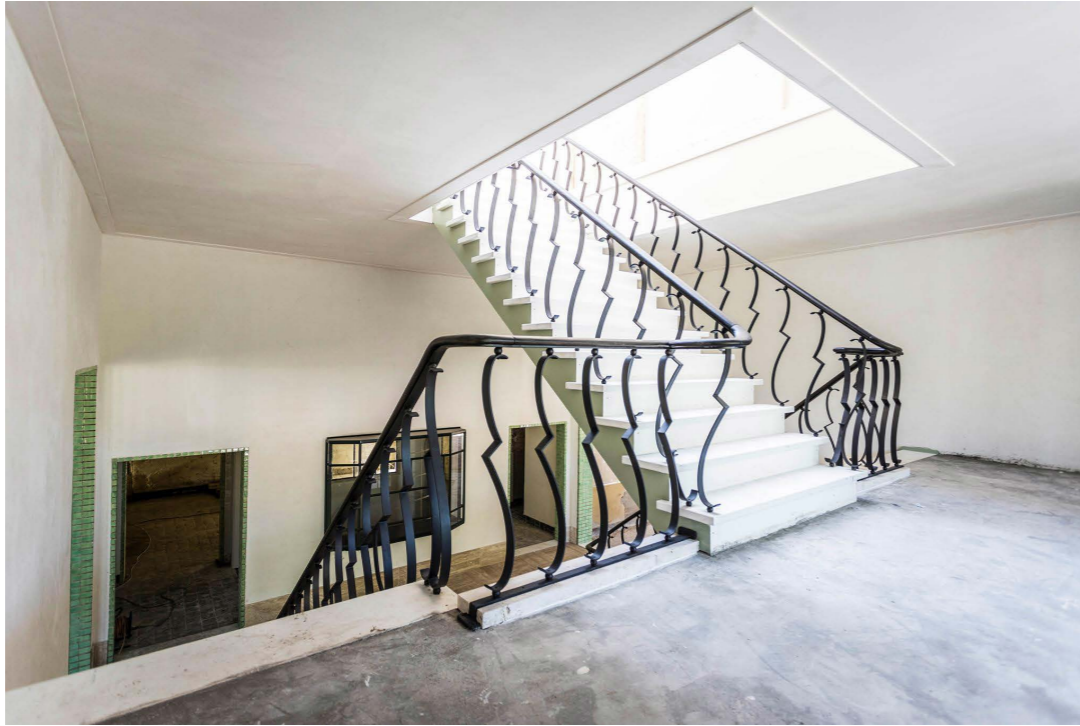
Afbeelding 5.4.56: Het trappenhuis na de restauratie
